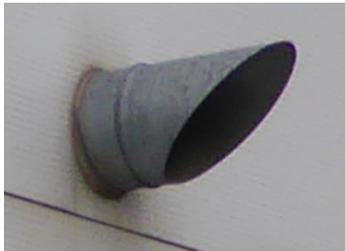
Il n'y a pas d'avancée du toit au-dessus de ces gaines. La dispersion verticale du gaz est donc rapide.
